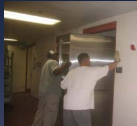
2. The top plenum thru 42" door
